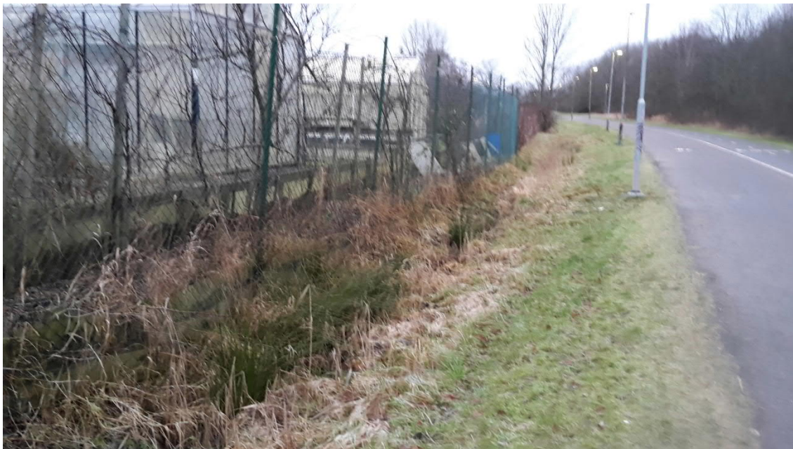
Figur 9. Dike längs med den östra sidan av område A där dagvatten släpps till dagvattennätet.
