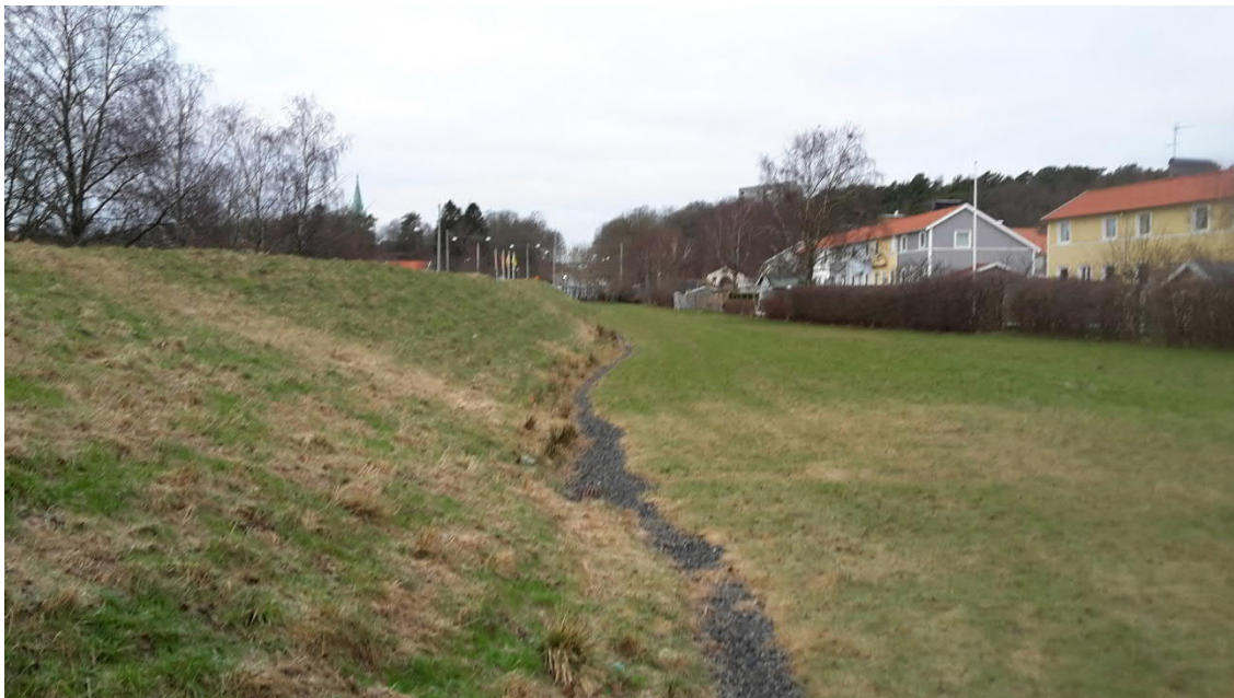
Figur 13. Makadamdike längs med bullervall i område C.
