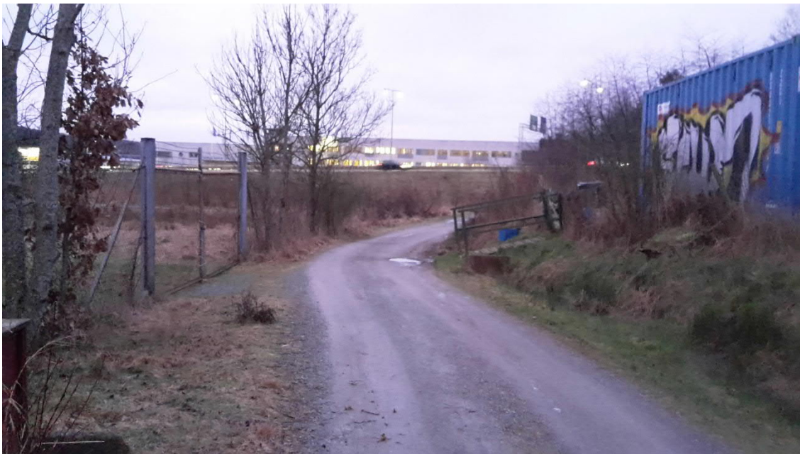
Figur 11. Järnbrotts Prästväg med tillhörande svackdike.
